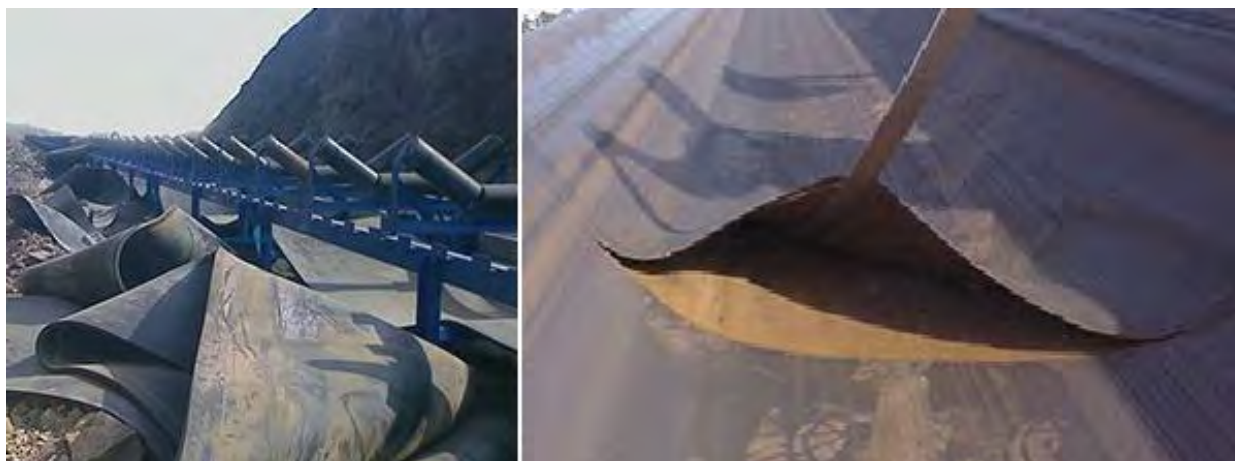
Рис. 1. Выход из строя транспортной системы в результате повреждения ленты конвейера Fig. 1. Failure of the transport system as a result of damage to the conveyor belt
